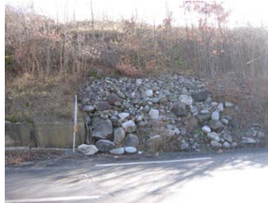
Enrochements déstabilisés
