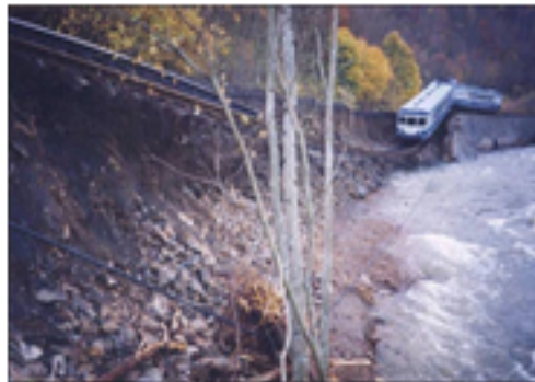
ECR 5 Désordres hydrauliques avec disparition du support de la voie
