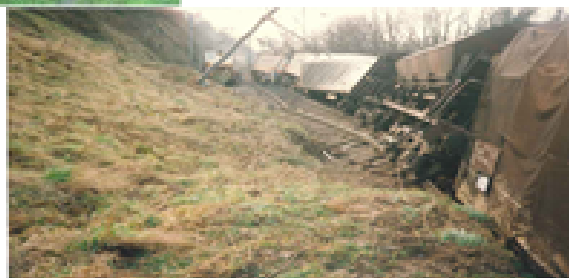
ECR 3 Glissements en déblais
