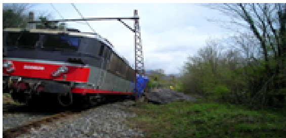
ECR 1 Eboulements et chutes de Blocs
