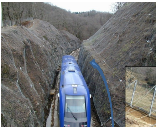
Barrière de prévention Grillage Plaqué Ancré
