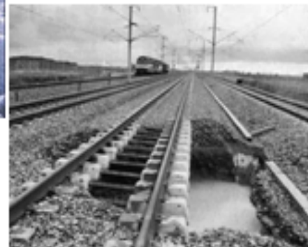
ECR 5 Désordres hydrauliques avec disparition du support de la voie
