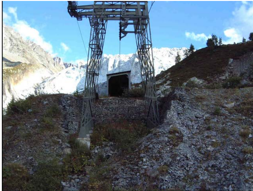
Fig. 4.9 – Photographie du dernier pylône devant la gare d'arrivée du téléphérique de la société "Electric Emosson SA".
