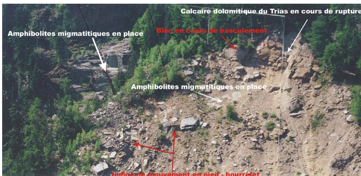
Figure 3 : Vue générale de l'arrachement sommital de l'éboulement de Charmonétier
