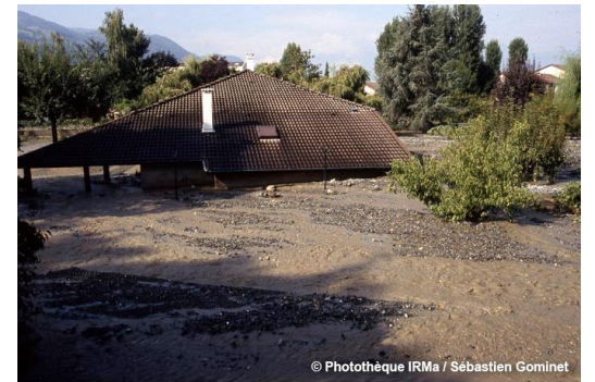
Torrential flod of Doménon, 2005
