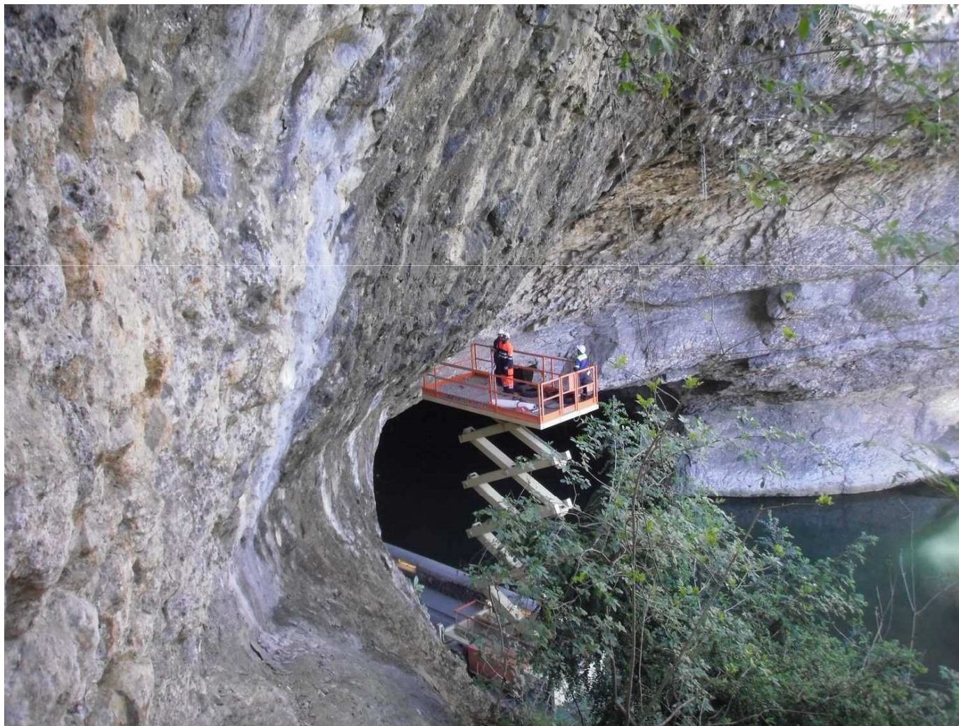
Inspection sur nacelle Entrée Nord
